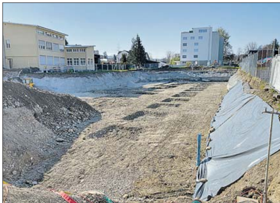
Zivital-Überbauung mitten im Dorfzentrum von Menziken: 25 Wohnungen auf fünf Stockwerken entstehen hier. (Bild: zVg.)
